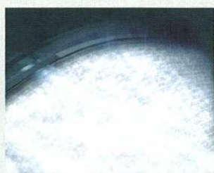
Обмерзание теплообменника
